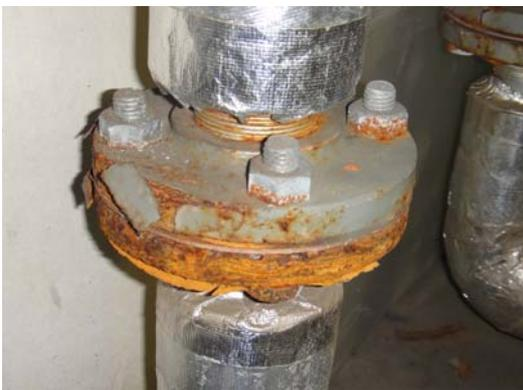
写真3 配管継ぎ手発錆
