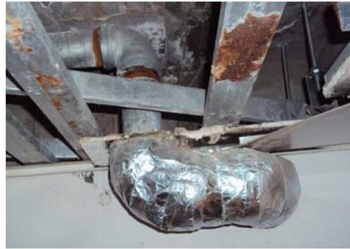
写真2 漏水による発錆等
